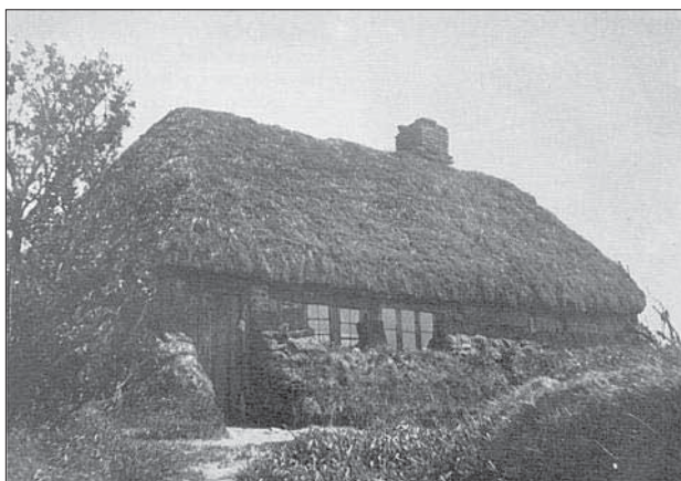
Gamle Trines hus med lyngblandet tag og opstablet lyngtørv på væggene. (1923)
